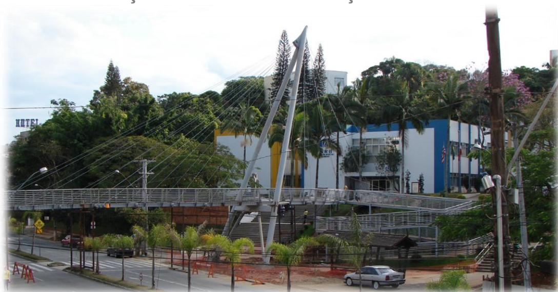
PASSARELA DA FURB – BLUMENAU/SC
