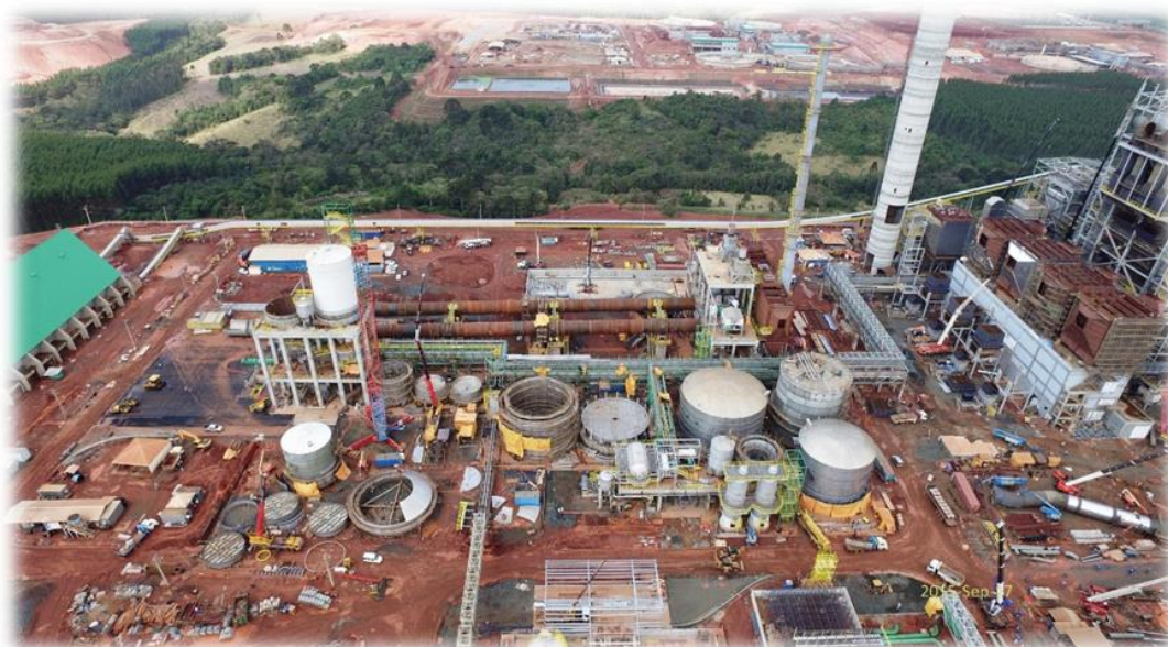
PROJETO PUMA – KLABIN - GEOTECNIA
