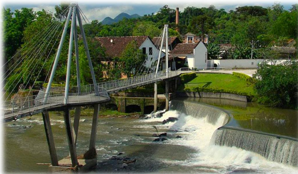
PASSARELA THAPYOKA – TIMBO/SC
